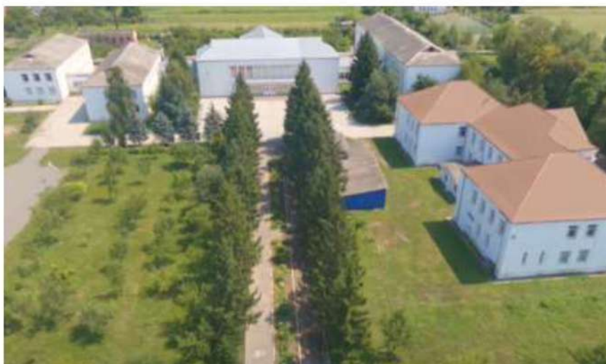
Рис. 2.10. Загальний вигляд будівель досліджуваної школи
