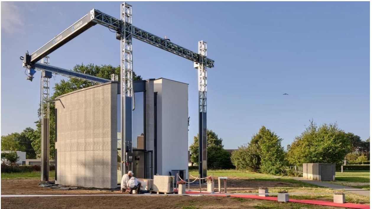
Рисунок 2.5 – будівництво споруд за допомогою 3D принтера
