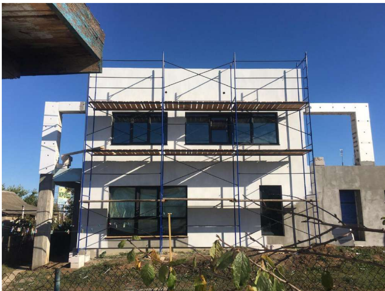
Рис.6.2. Риштування влаштоване для фасадних робіт
