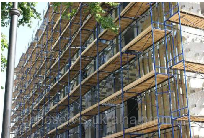
Рис.6.2. Риштування влаштоване для виконання фасадних робіт
