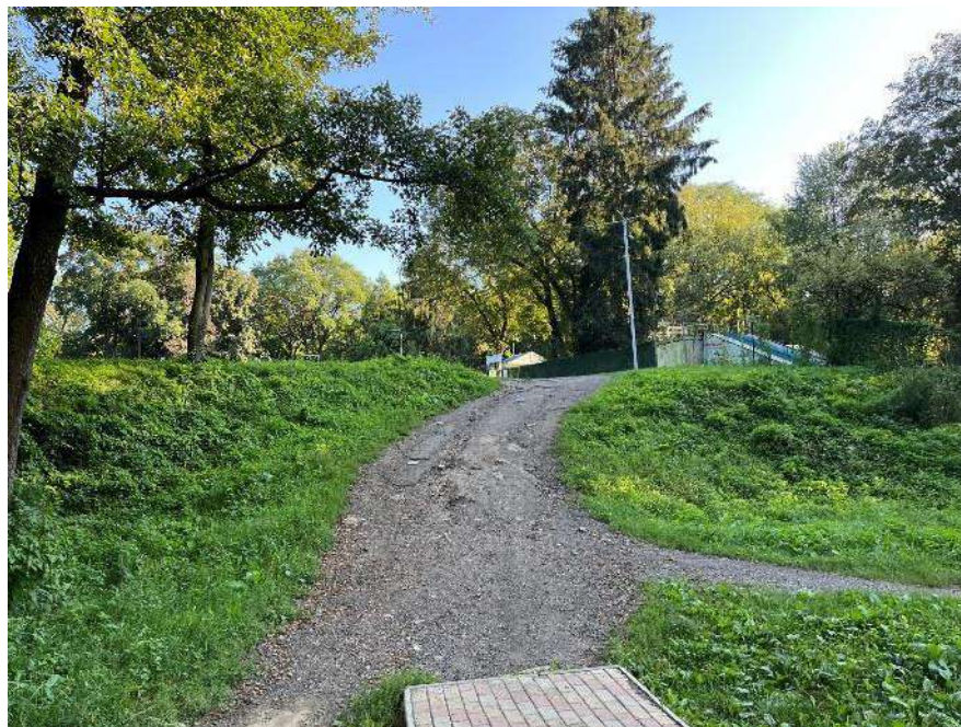
Рис.1.5.2 Доріжки з пошкодженим покриттям та ненормативним ухилом
