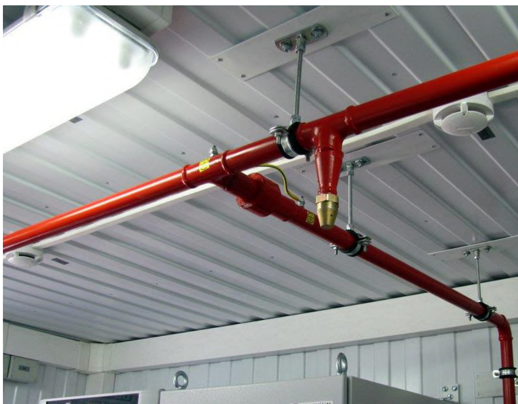
Рис. 2.6 Спринклерна система паркінгу
