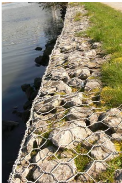
Рис 1.3. - Приклад укріплення берегової лінії габіонами
